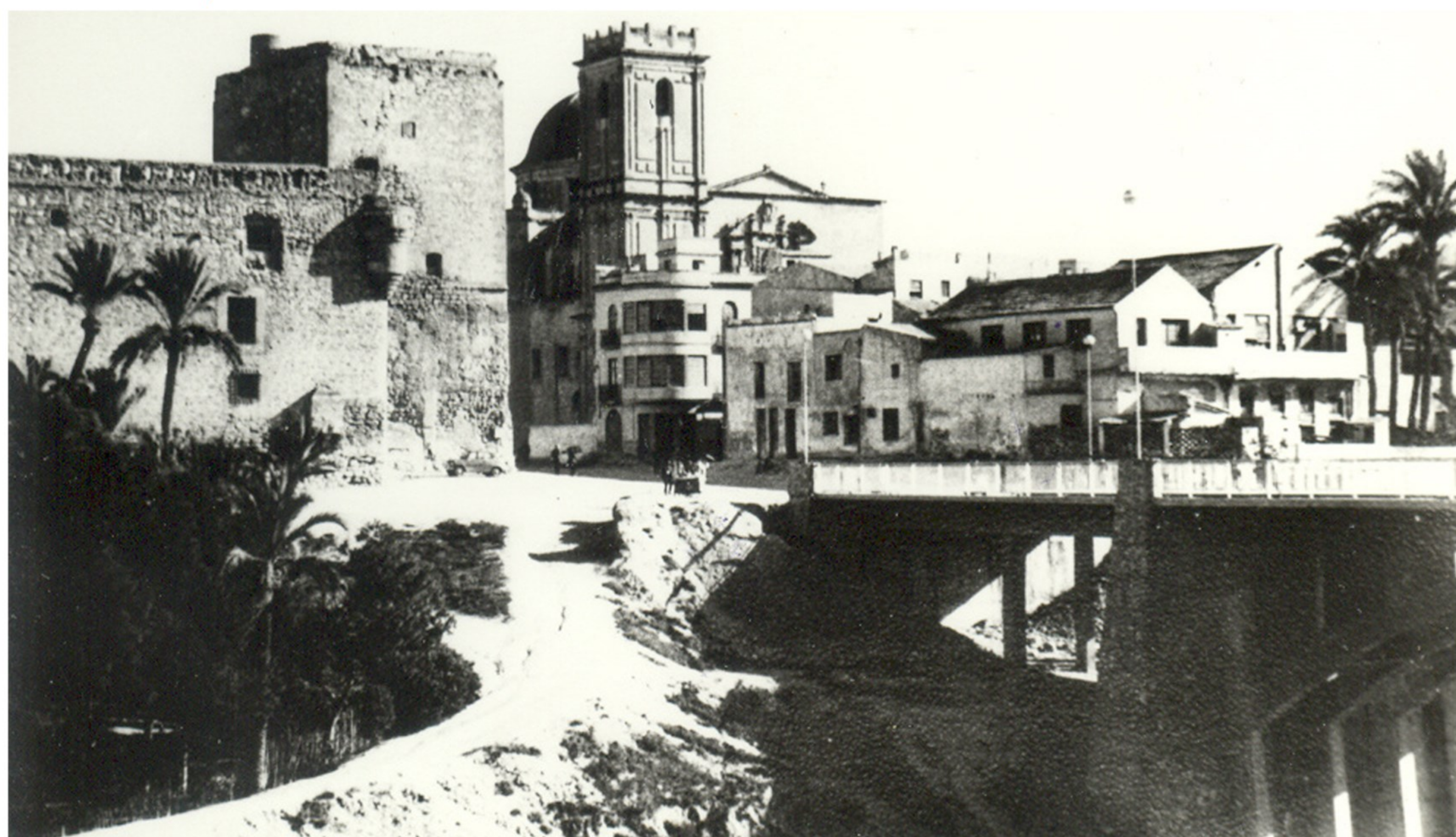
Palacio de Altamira restaurado, 1982
