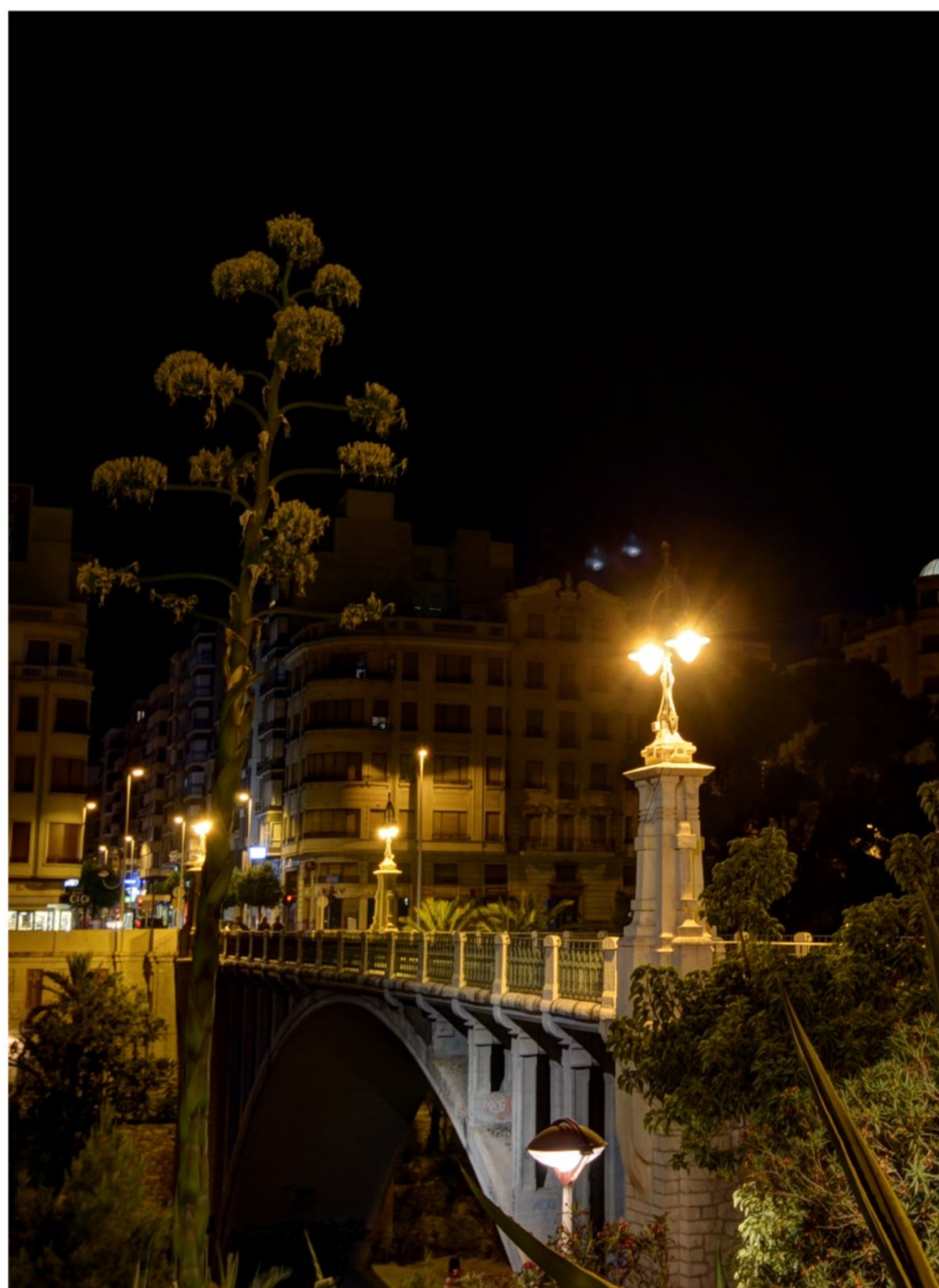
Imagen de portada: Puente de Canalejas sobre el Río Vinalopó.
