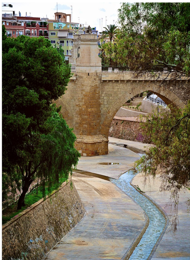
Imagen de portada: Puente de Santa Teresa sobre el Río Vinalopó.
