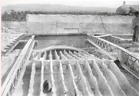
Figura 8: Fotografía realizada por Pere Ibarra y digitalizada por Jerónimo Guilabert, de las obras de sustitución de la cubierta. Se observan las cerchas nuevas apoyadas sobre pilastras adosadas a los muros.
