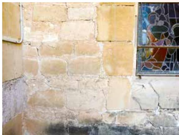
Figura 5: Detalle del cerramiento de la nave central visto desde la terraza norte. Se observan sillares reaprovechados con signos gliptográficos.
