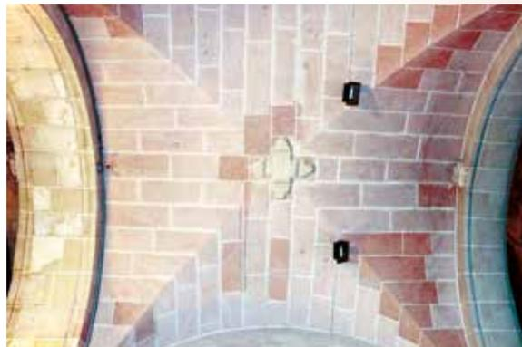
Figura 9: Detalle de las bóvedas de arista en capilla con revestimiento sobre piedra.
