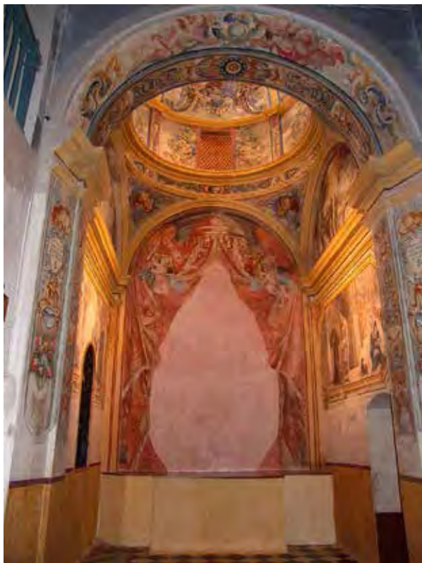
Fig. 19 Fotografía general de la capilla después de la intervención.
