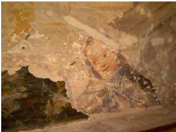
Fig. 7 Proceso de eliminación del añadido.
