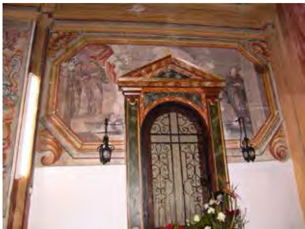
Fig. 6 Detalle del muro lateral izquierdo antes de la intervención.
