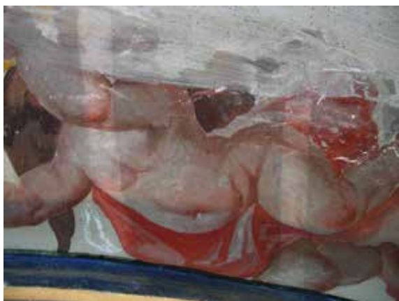
Fig. 10 Detalle del arco de medio punto de entrada a la capilla antes de la intervención.
